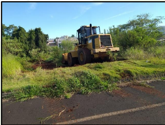
Limpeza do local para realização da sondagem
