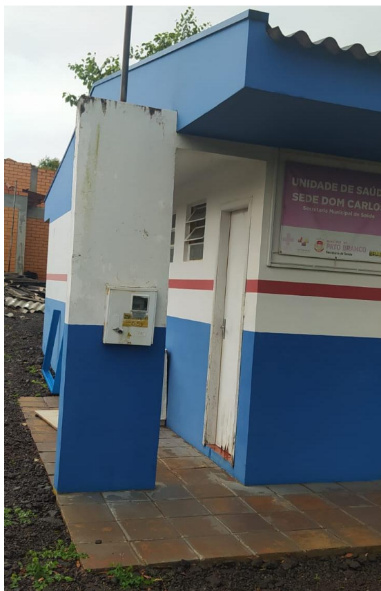
Foto 04: Hall de acesso ao banheiro.
