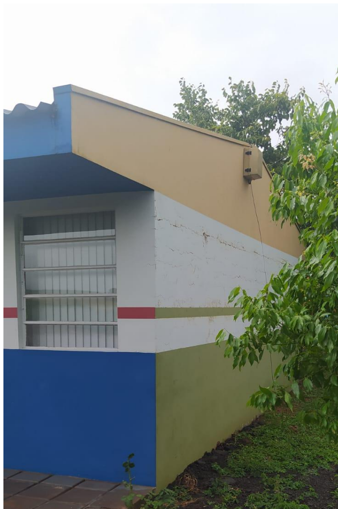
Foto 09: Pintura antiga em apenas um dos lados da edificação com fissuras.
