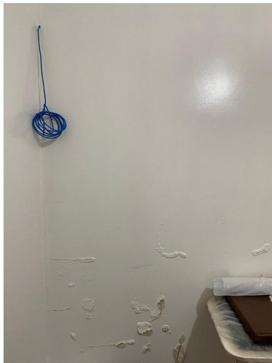
Foto 8: Danificação na pintura e bolhas.
