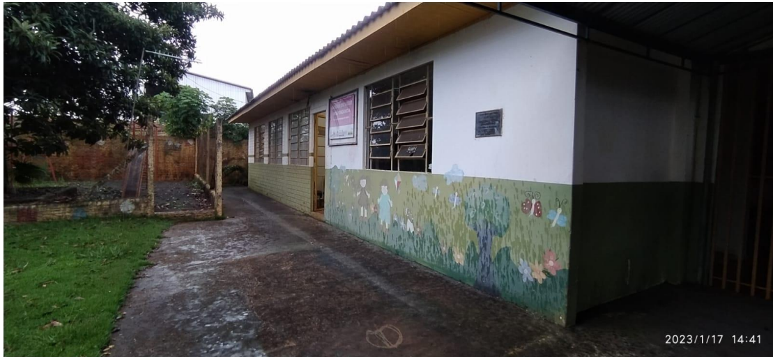
Foto 3: Fachada Principal da unidade.
