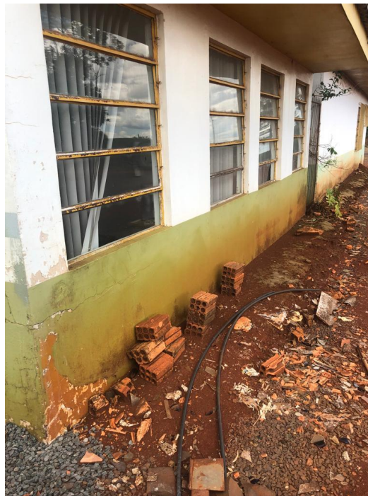
Foto 04: Fachada dos fundos.
