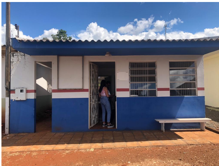
Foto 01: Fachada Frontal da unidade Passo da Ilha.
