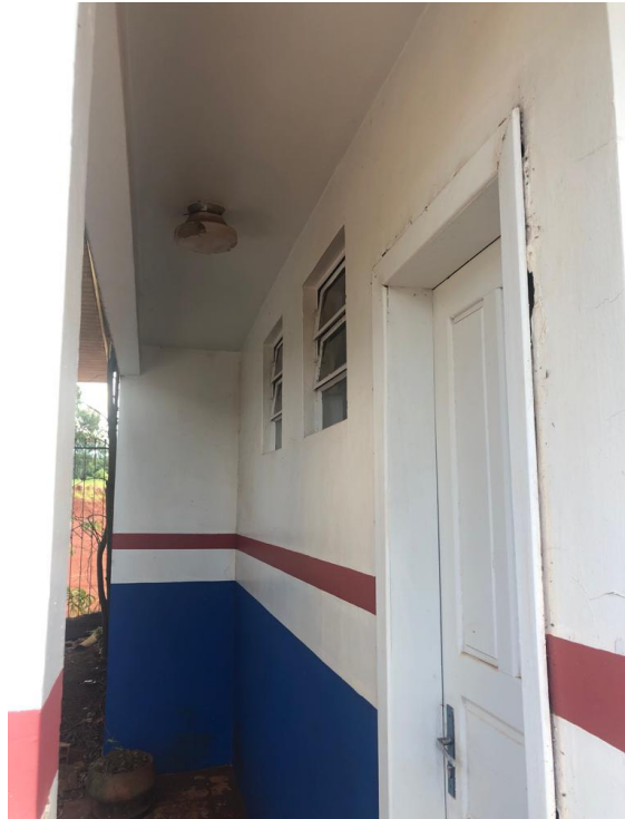
Foto 03: Hall de acesso ao banheiro social.
