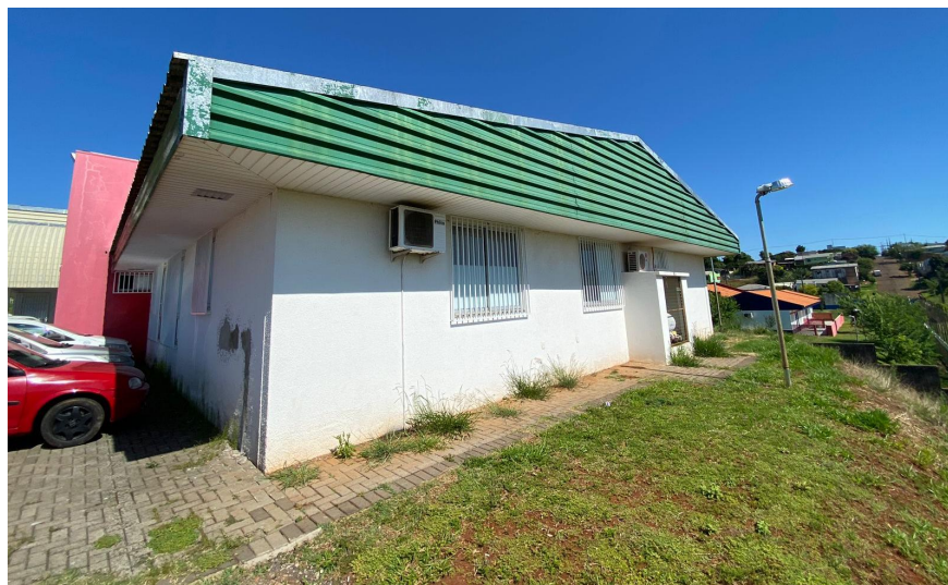
Foto 04: Fachada Lateral Oeste.
