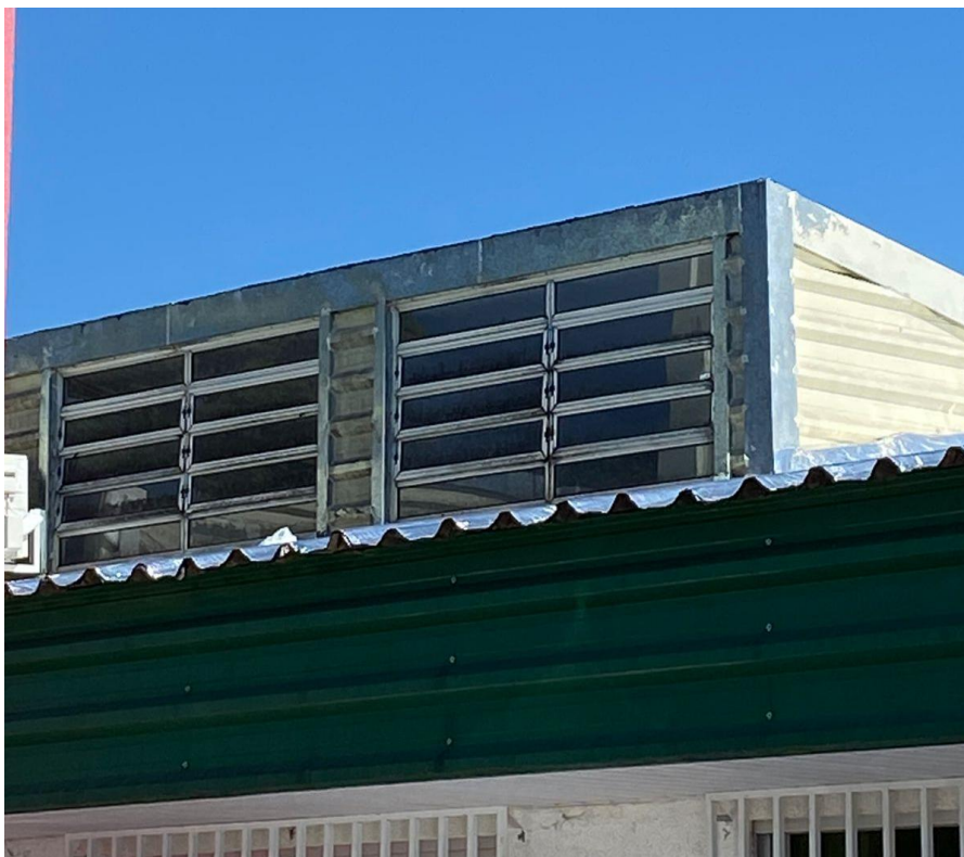
Foto 07: Iluminação Zenital tipo SHED .
