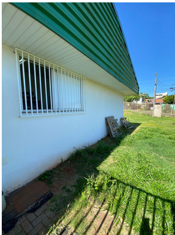
Foto 06: Fachada Lateral leste.
