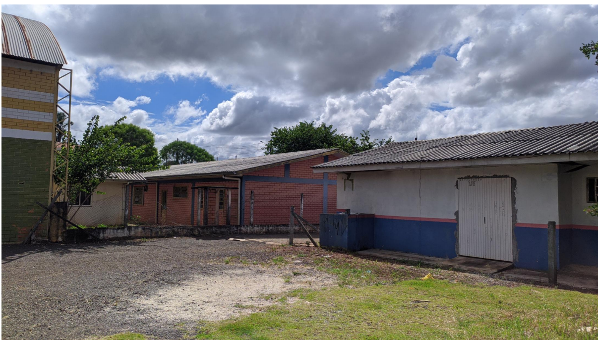
Fundos dos edifícios.
