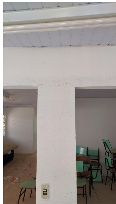
Espaço interno da estrutura do antigo posto.
