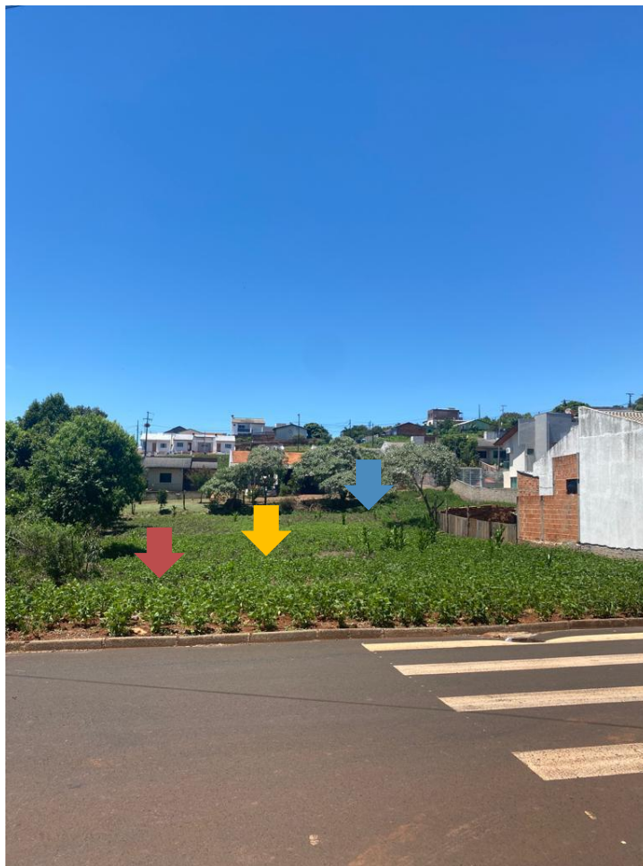
Imagem 3: Vista da Rua Aurea Zandona .Criação de acesso para as áreas de convivência e jogos (vermelho), implantação de cerceamento da praça (azul) e nivelamento do terreno (amarelo).
