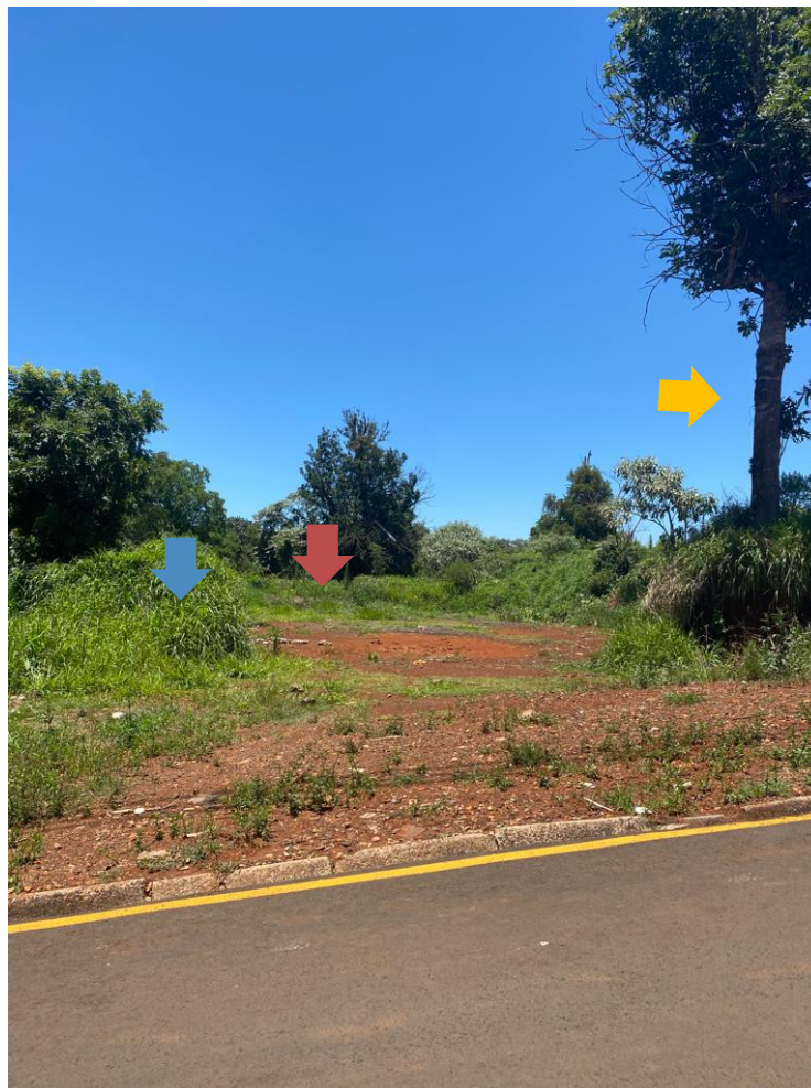
Imagem 1 Vista da Rua Ângelo Gabriel. Limpeza do terreno e remoção de vegetação de forração (azul), ajuste na topografia para implantar a quadra (vermelho) e remoção de árvores (amarelo) .
