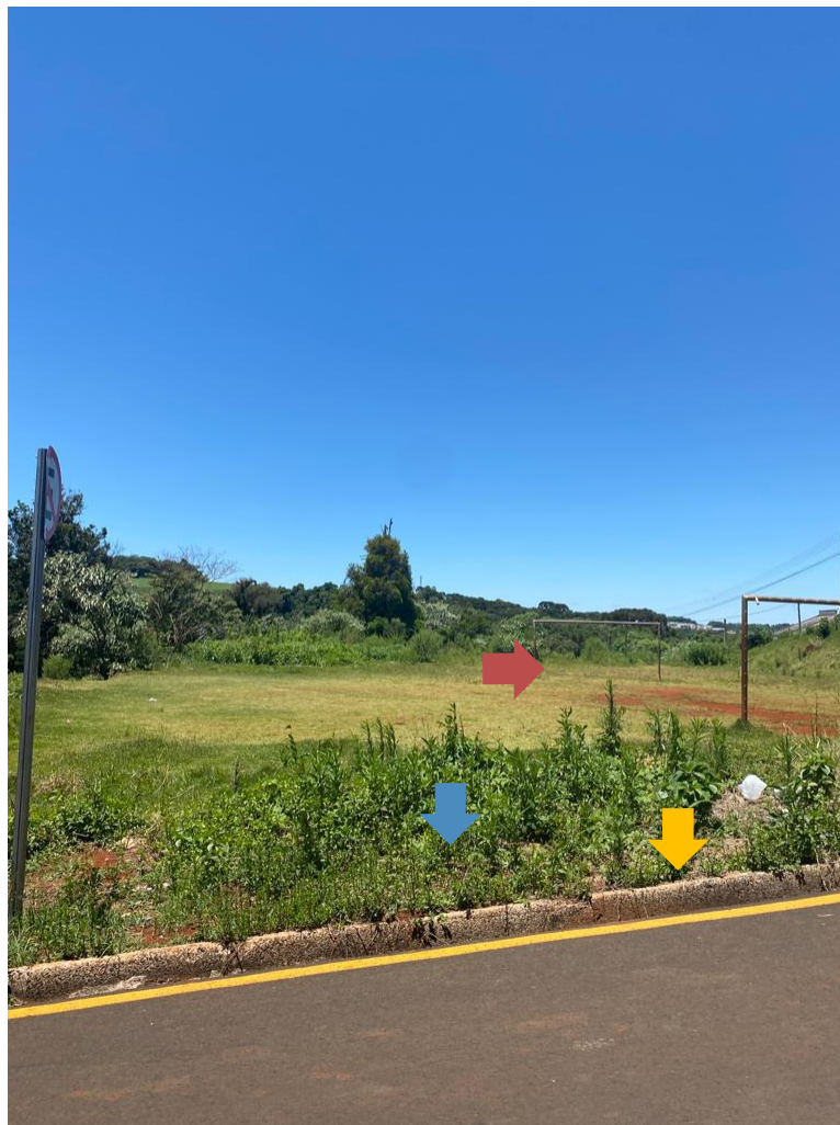
Imagem 4 Vista da Rua Ângelo Gabriel. Limpeza do terreno e remoção de vegetação de forração (azul), remoção e substituição das traves de gol (vermelho) e aplicação de calçada (amarelo).
