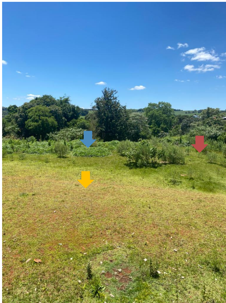
Imagem 6 Vista da Rua dos Jasmins. Limpeza do terreno e remoção de vegetação de forração (azul), aplicação de cercamento (vermelho) e substituição das traves de gol (amarelo) .
