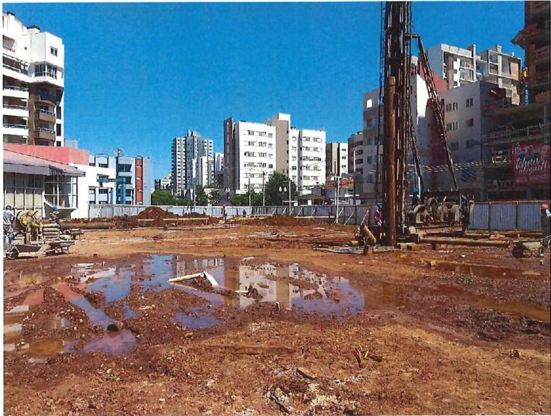
Foto 03: Estacas Franki – vista 02
