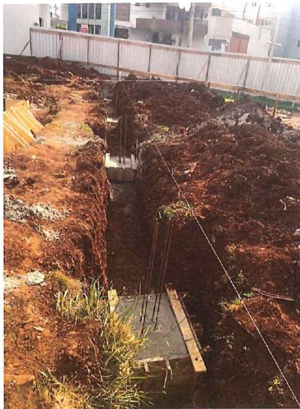
Foto 06: Blocos de Concreto – vista 03
