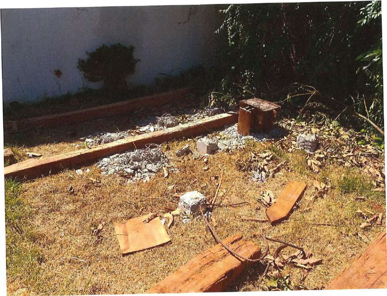
Foto 07: Estacas pré-moldadas do Reservatório
