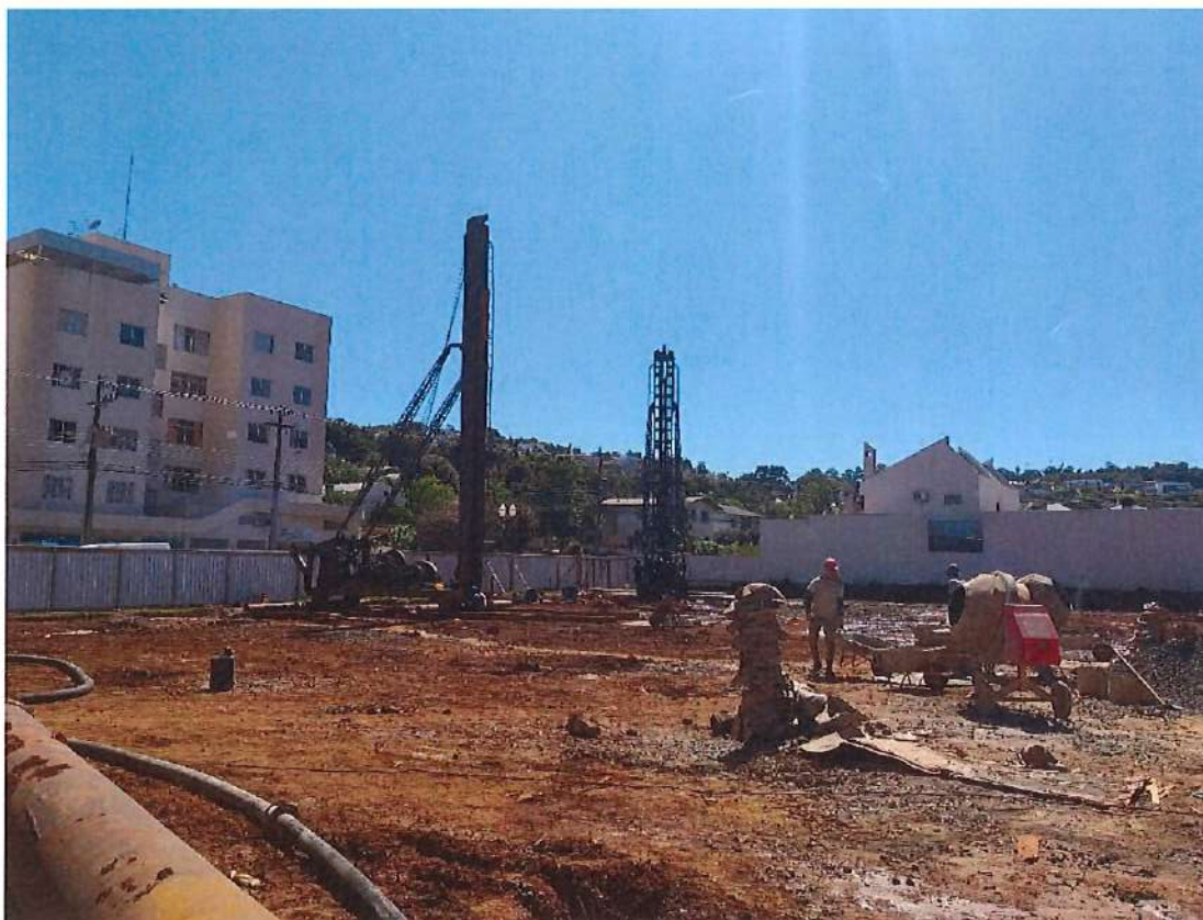
Foto 02: Estacas Franki – vista 01
