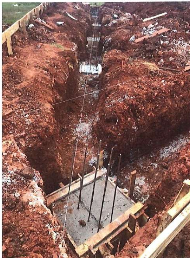
Foto 04: Blocos de Concreto – vista 01
