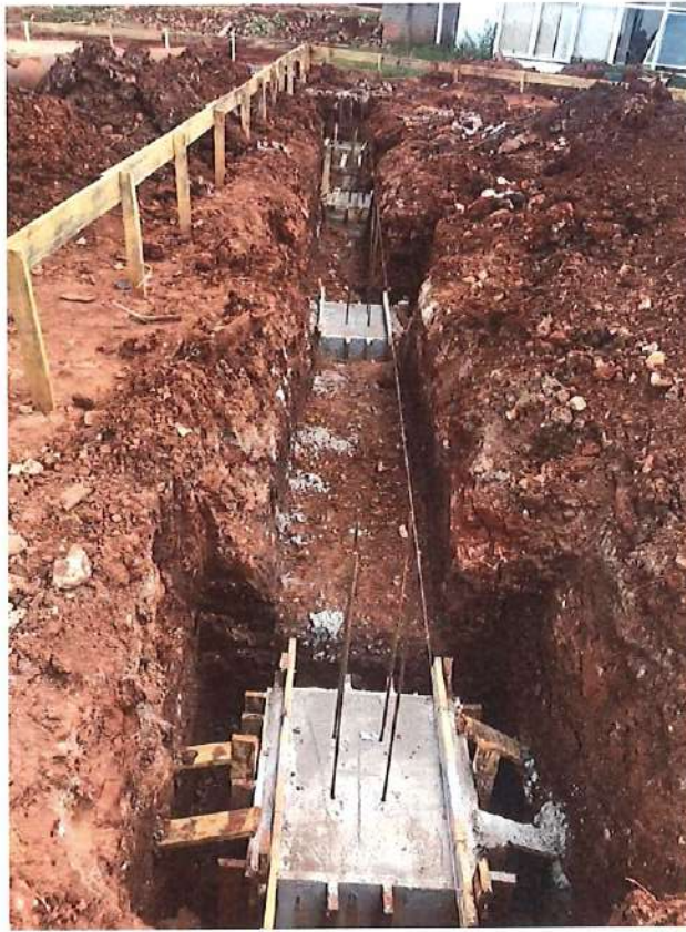
Foto 05: Blocos de Concreto – vista 02
