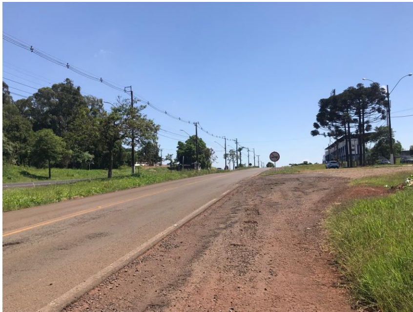
Figura 35 - Registro fotográfico das condições de calçada no terreno
