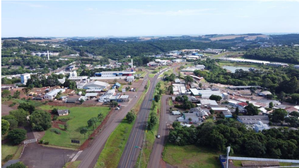
Figura 44 - Viaduto entre a Avenida Tupi e a Rodovia BR 158.
