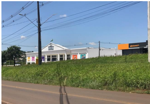
Figura 14 - Havan - vista do terreno da Arena
