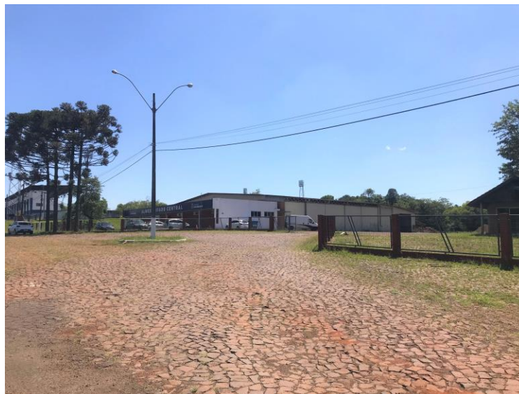
Figura 41 - Poste existente em frente ao terreno da Arena
