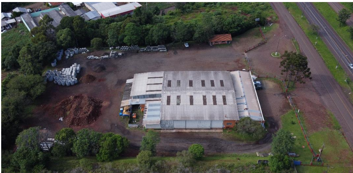
Figura 6 - Edificação em alvenaria existente.
