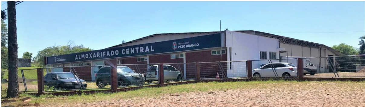
Figura 7 - Edificação em alvenaria existente.
