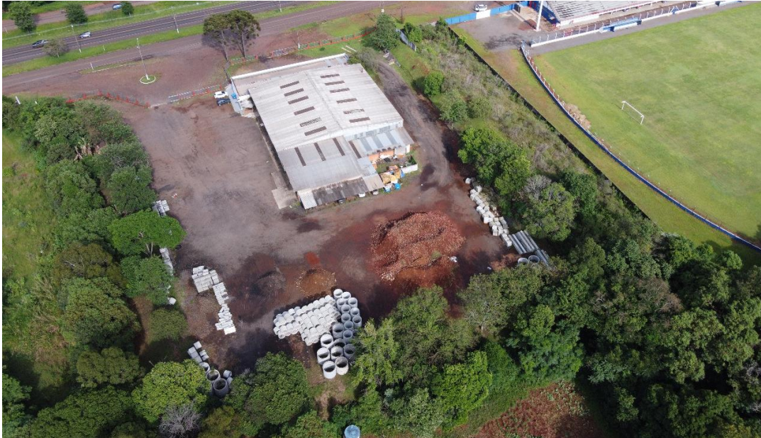
Figura 4 - Edificação em alvenaria existente
