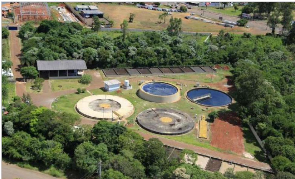
Figura 87 – Estação de Tratamento de Esgoto de Pato Branco
