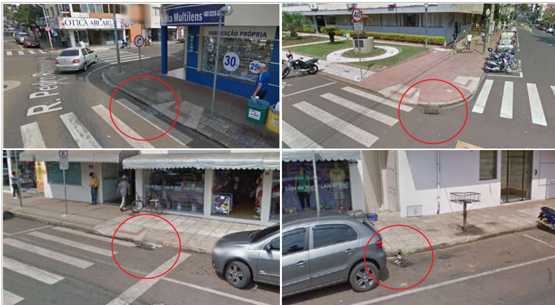
Figura 90 – Bocas de lobo nas vias que circundam a Praça Rotary
