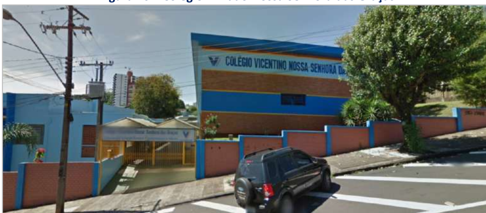
Figura 70 – Colégio Privado Nossa Senhora das Graças
