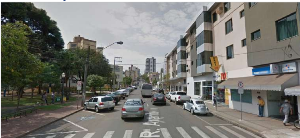
Figura 132 – Rede elétrica aérea na Rua Araribóia – ADA
