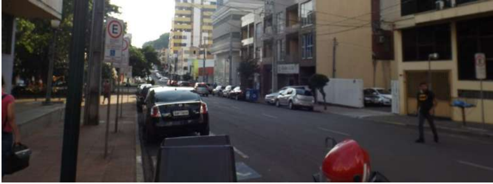
Figura 85 – Pavimentação asfáltica – Rua Pedro Ramires de Mello
