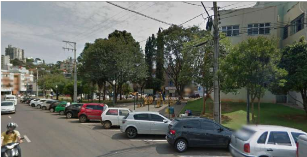
Figura 8 – Imagem da área de implantação do terminal urbano – vista da Rua Araribóia
