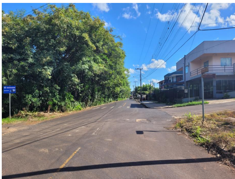
Figura 02: Registro fotográfico Rua João Penso - ausência de calçada
