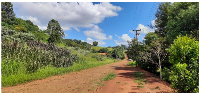
Figura 08: Registro fotográfico da rua Vicente De Col - área não parcelada com pavimentação poliédrica
