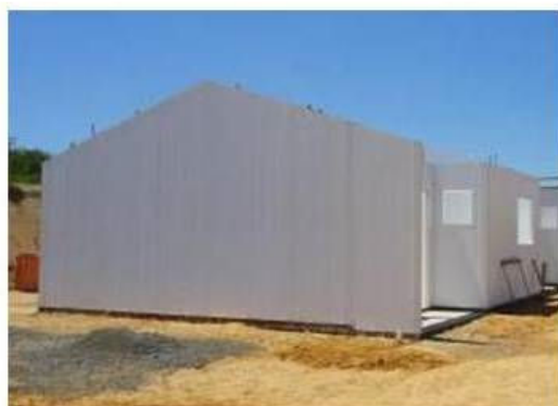
Figura 19 – Painéis de PVC concretados
