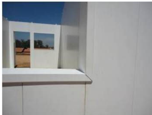
Figura 20 – Abertura das janelas com acabamentos em PVC
