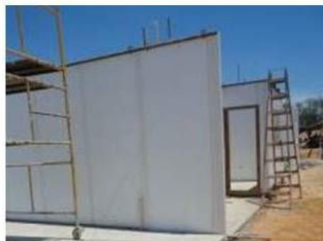
Figura 14 – Painéis de PVC posicionados e escorados
