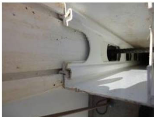
Figura 15 – Ferragem posicionada na região da contra-verga
