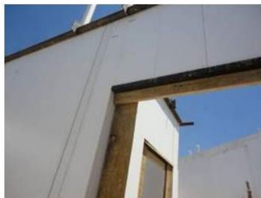
Figura 16 – Escoramento de aberturas de portas para concretagem
