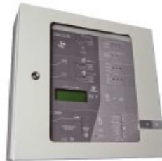
CENTRAL DE ALARME DE INCÊNDIO ENDEREÇÁVEL INC 2000
