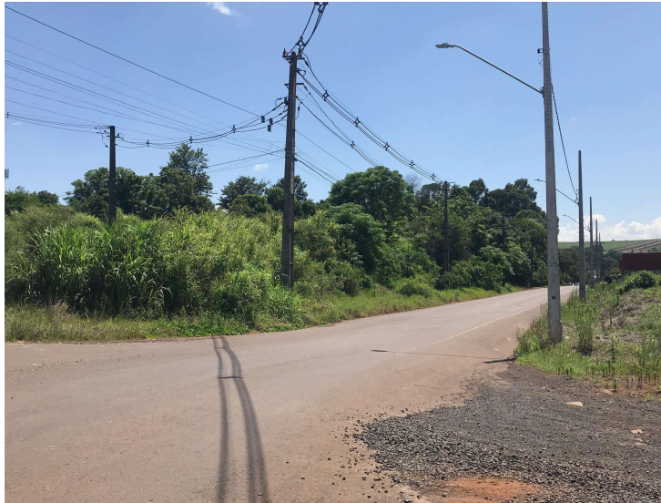
Figura 36 - Registro fotográfico da (ausência de) faixa de travessia Rua Parigot de Souza
