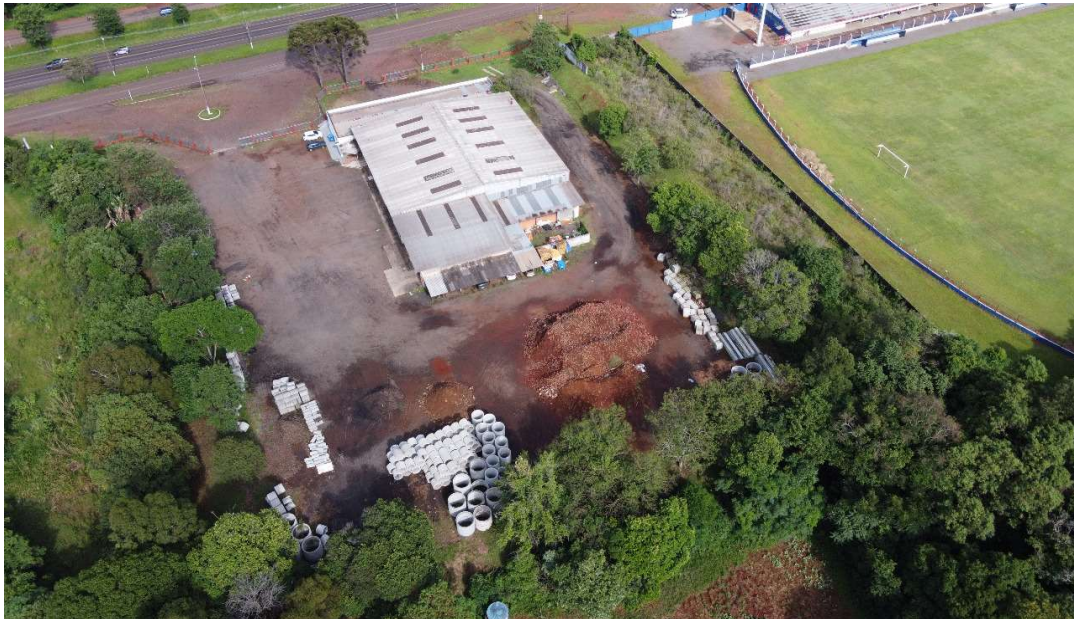
Figura 4 - Edificação em alvenaria existente
