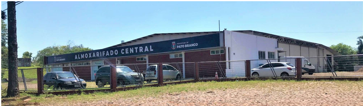
Figura 7 - Edificação em alvenaria existente.
