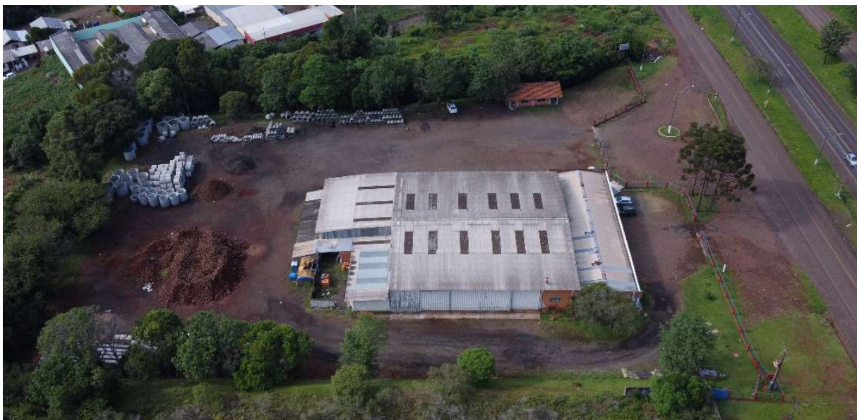
Figura 6 - Edificação em alvenaria existente.
