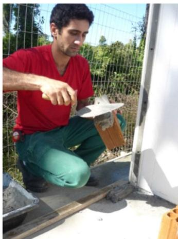
Foto 5 e 6) Assentar bloco cerâmico com argamassa.
